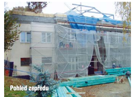
Budova bez střechy
