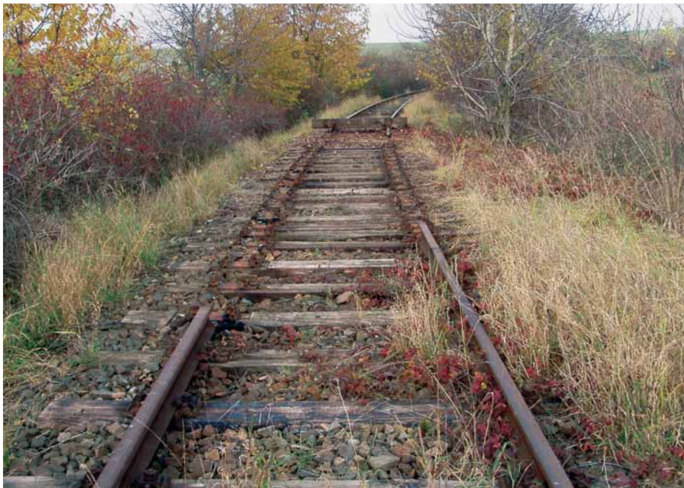
Na zrušené železniční trati Uhřetice–Ždánice se buduje cyklostezka. Při demontáži kolejnic zdatně pomáhají zloději starého železa
