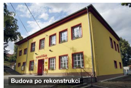
Rekonstrukce obecního úřadu, 2013
